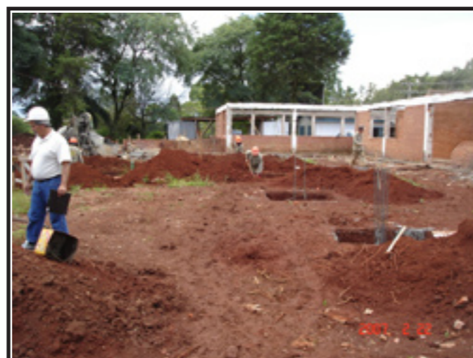
Unidade será construída próxima à BR285
