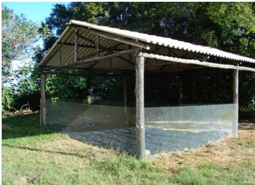
Figura 2: Estrutura para o segundo estágio de compostagem
