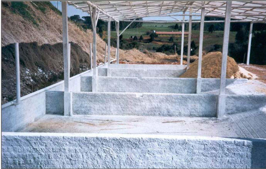
Figura 8: Tanques padrão e rampas de acesso Fonte: Dai Prá (2009)
