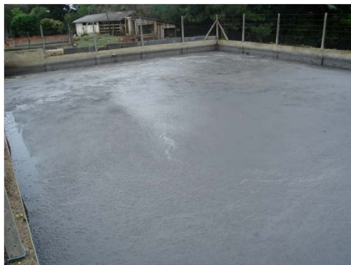
Figura 1: Esterqueira em alvenaria Fonte: Valente (2007)
