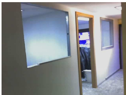
Divisórias de gesso acartonado
