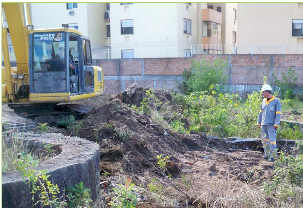
DPO coordena serviços de desmontagem da chaminé, remoção de elementos construtivos e limpeza do terreno que receberá a futura sede própria da reitoria
