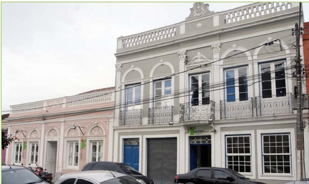
Prédio histórico abriga quatro das cinco pró-reitorias do IFSul
