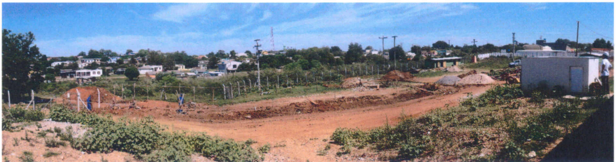
Vista do Canteiro de Obras em 16.02.2012
