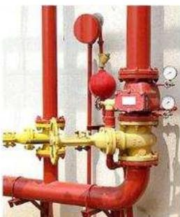
Apresenta corpo fabricado em ferro fundido nodular, conexão flange x flange, padrão *ANSI B 16.5*, trabalha com uma Pressão máxima de trabalho: 175 PSI e pintura na cor vermelha (Referência: PTF 1268).
